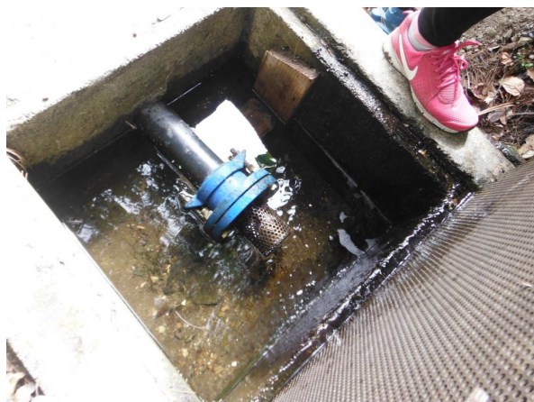
Figure 4 : Photographies du captage de Petit-Atéou en 2014
