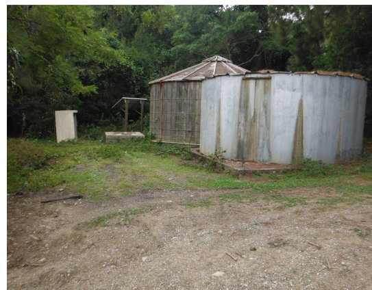
Figure 6 : Réservoir de Petit-Atéou
