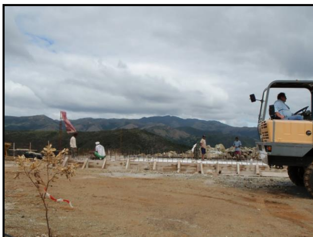
Photo 4 : Réservoir en construction (HYTEC, 15/06/09)
