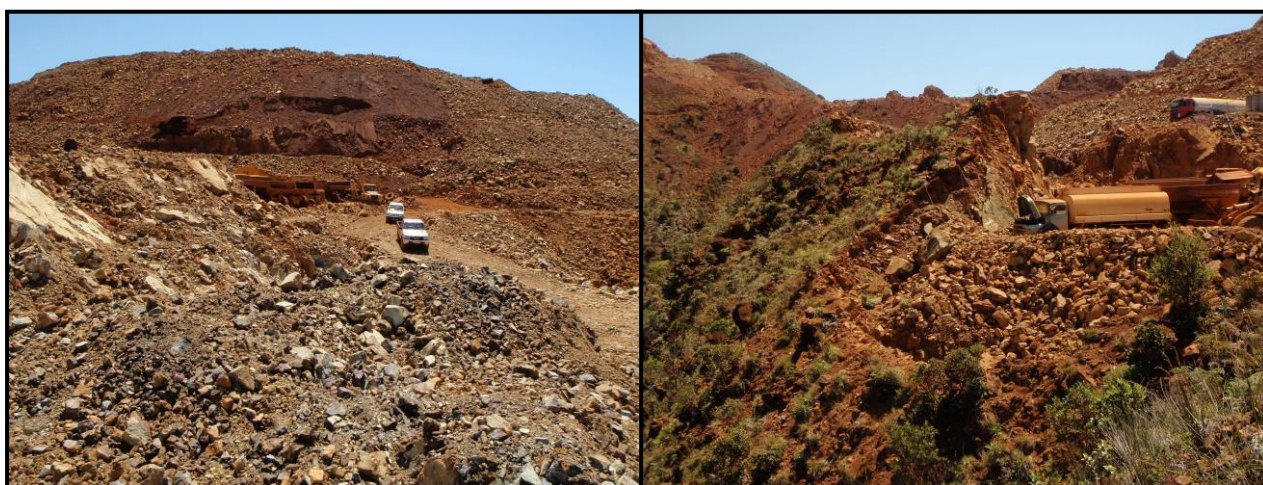
Photo 6 : Stockage des matériaux (à gauche) et entreposage des engins (à droite) – HYTEC, le 18/09/09
