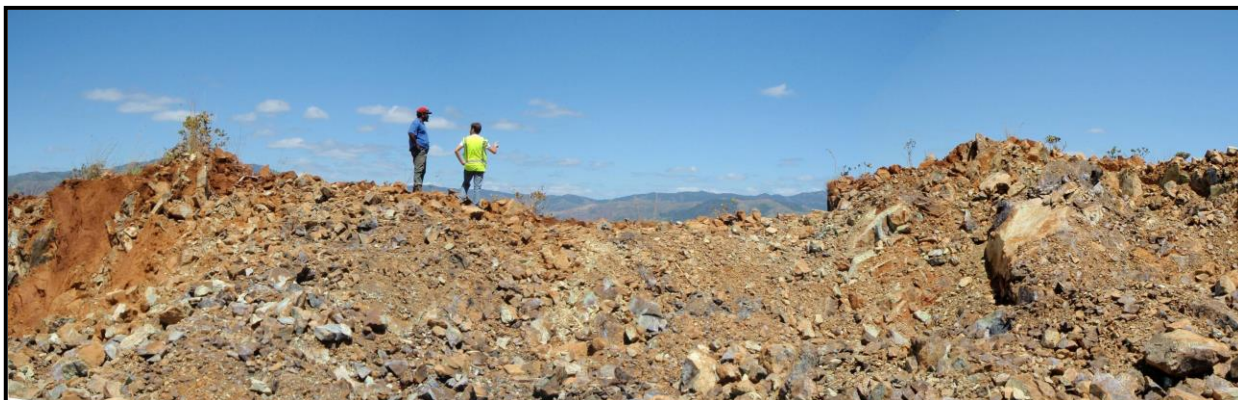
Photo 7 : Merlons de protection en amont des captages (HYTEC, 18/09/09)
