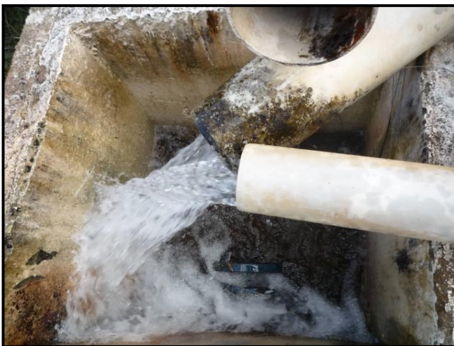
Photo 12 : Vue de l'intérieur de l'ouvrage de captage de la source (HYTEC, 15/06/09)
