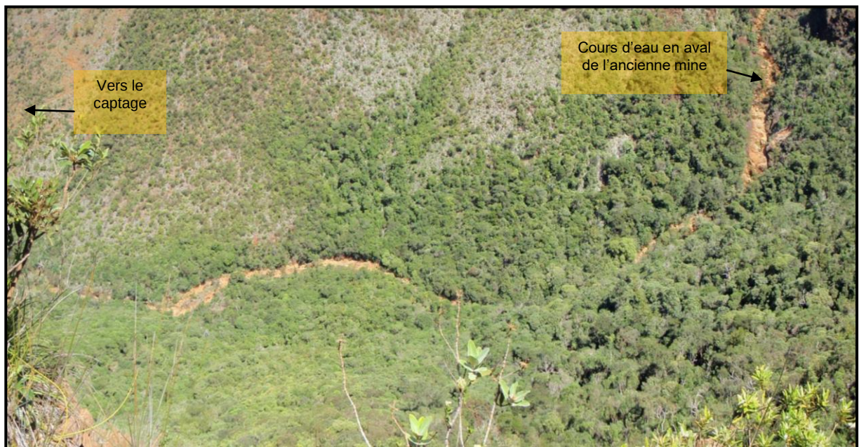
Photo 9 : Erosion du cours d'eau par les éboulements de l'ancienne mine (HYTEC, 18/09/09)
