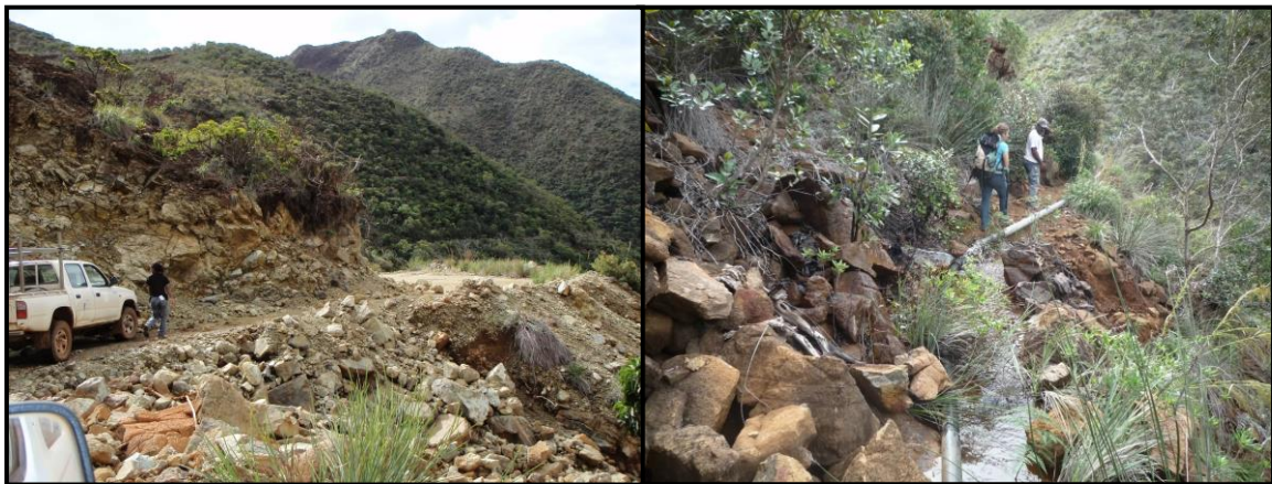
Photo 1 : Etat de la piste d'accès après le nouveau réservoir (à gauche), sentier longeant la canalisation d'adduction (à droite) – HYTEC, 15/06/09
