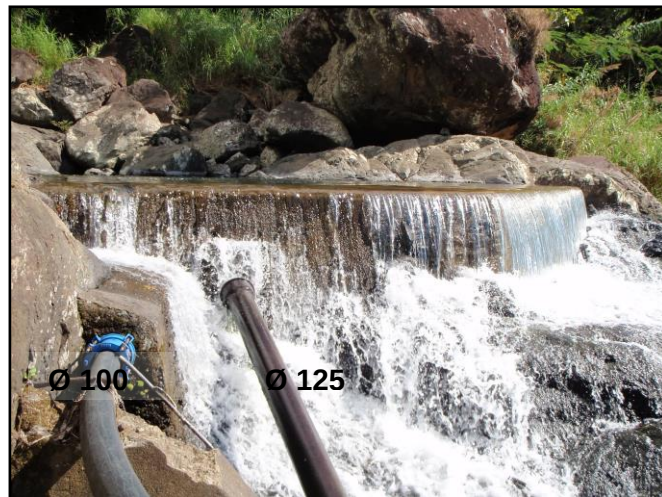
Figure 3 : Photographie du seuil déversant et des deux conduites d'adduction du captage de Méhoué (vue depuis l'aval rive droite)
