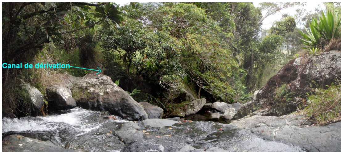
Figure 1: Photographie du canal de dérivation en amont du captage de Méhoué
