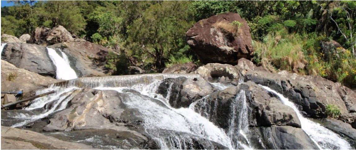
Figure 2 : Photographie du captage de Méhoué vu depuis l'aval
