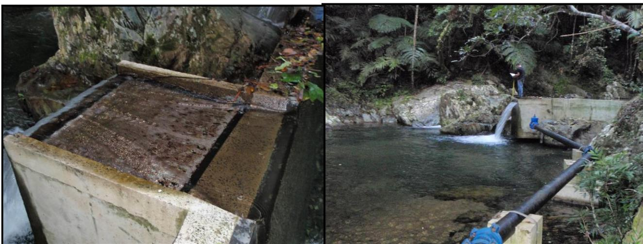
**Photo 5 : Grille de protection de la chambre de pompage (à gauche) ; canalisation en fonte Ø160 mm au départ du captage de Mia (à droite) - HYTEC, le 15/06/09**
