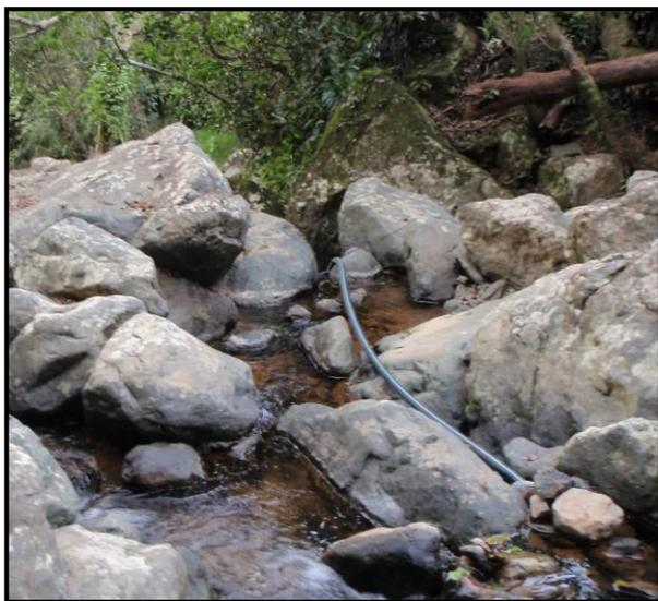
**Photo 3 : Tuyau de la prise d'eau de Nigu retenue par des cailloux**
