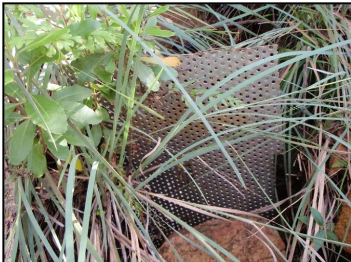
*Photo 4 : Plaque inox percée de trous installée en sortie du trou d'eau de la source (HYTEC, le 15/06/09)*
