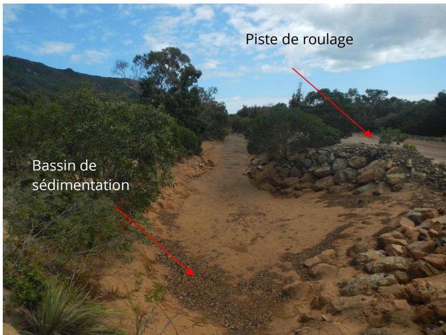
**Figure 12 : 8642 Bassin de sédimentation RTE007**
